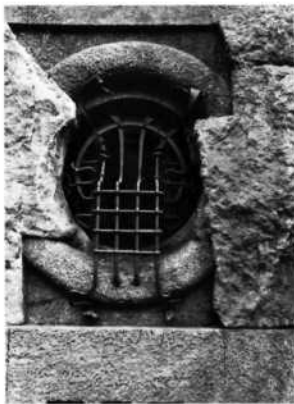
895, 896 - G. BOMMARUGA, particolari del palazzo Castiglioni, Milano, 1903.
