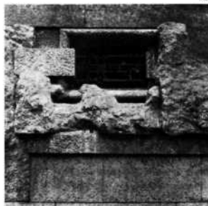
897 - ANTONIO VANDONE, Casa Maffei, Torino; particolare (rilievi di Alloadi, ferri battuti di Mazzucotelli).
