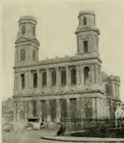
FIG. 183.—FAÇADE OF ST. SULPICE, PARIS.
