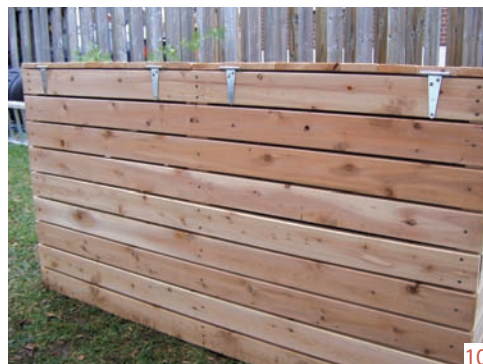
Installation des charnières
