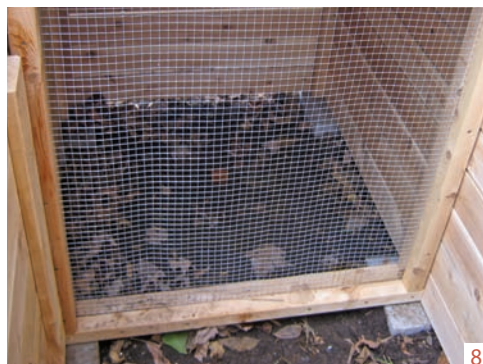
Installation du grillage
