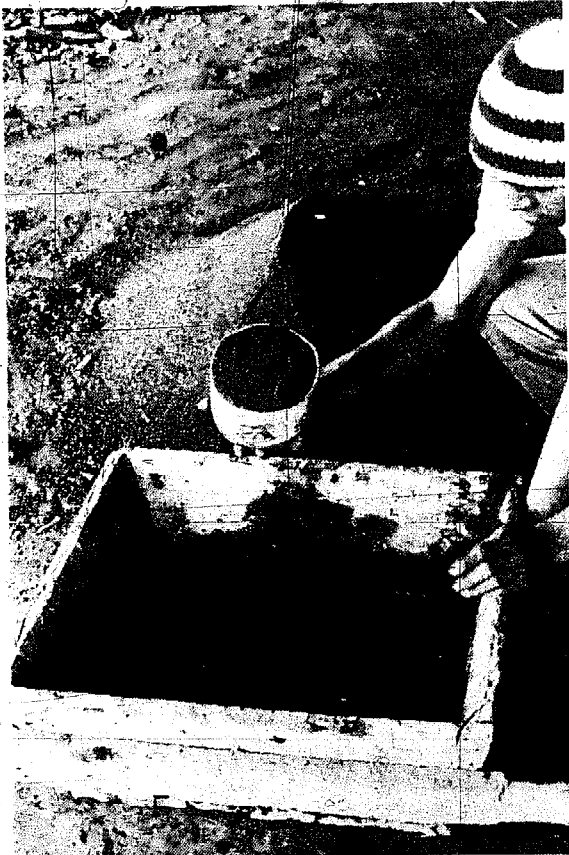
Figura 4-3. Para medir las proporciones de la mezcla, puede utilizarse un tarro de galletas.
