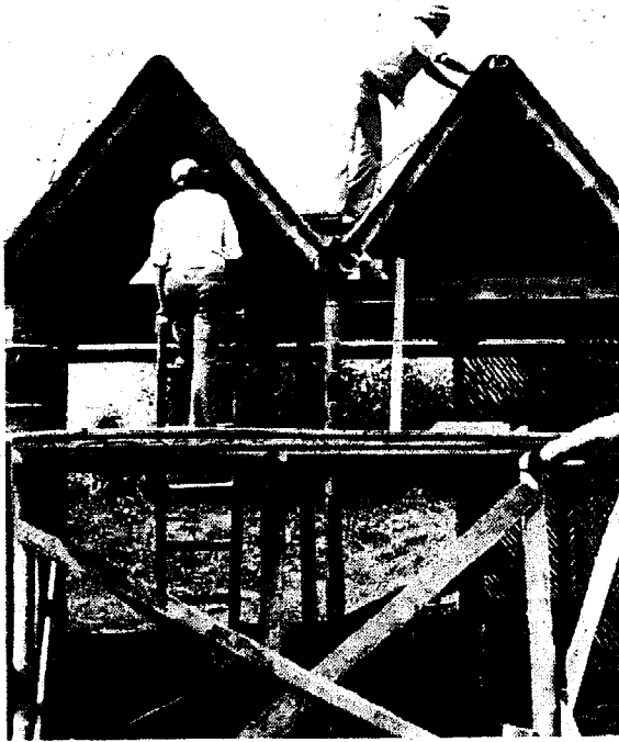
Figura 3-27. Debe construirse un andamio para colocar una lina con agua y el mortero preparado.
