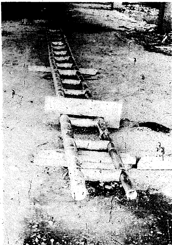
Figura 3-18. Construcción del alero final. Para que el ancho del alero quede igual a todo lo largo, se utiliza una guía de madera en la forma como se indica en la figura.
