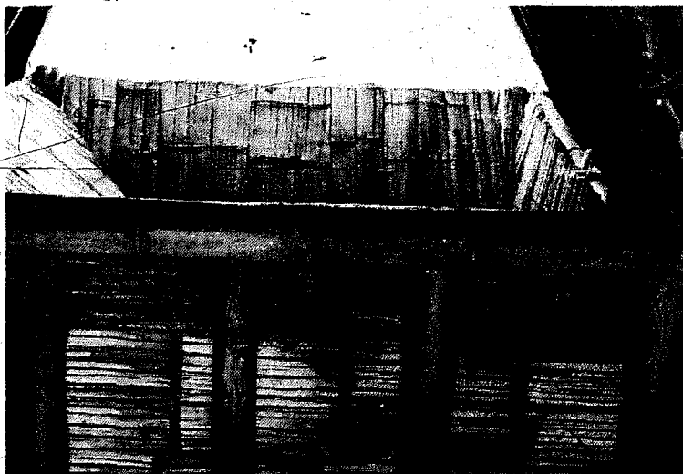
Figura 2.25. Además de las piezas indicadas en la figura anterior deben colocarse piezas intermedias horizontales sobre las cuales se asegura la esterilla.
