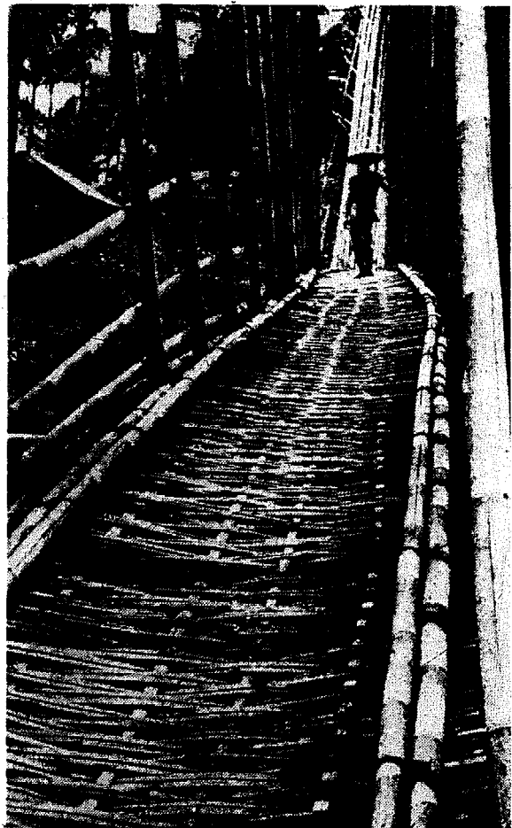
Figura 1-37. Puente atirantado de bambú originario de Java y Borneo. Nótese la limpieza del acabado de la estructura y del piso.
