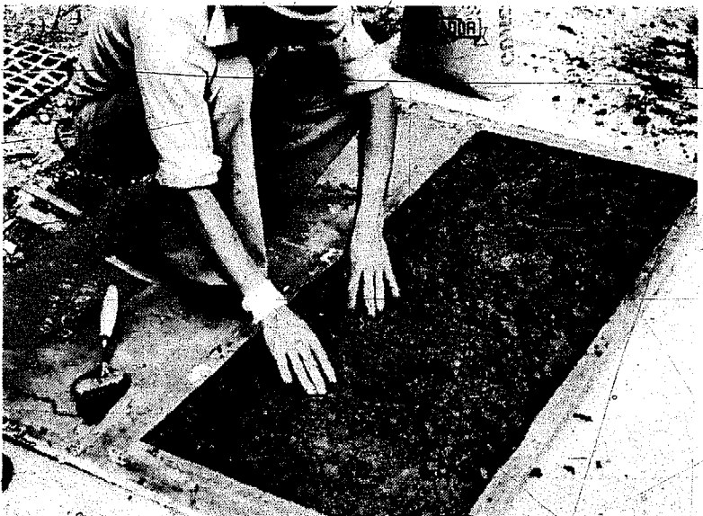
Figura 4-30 Aplicación de la primera capa de mortero sobre la base de madera
