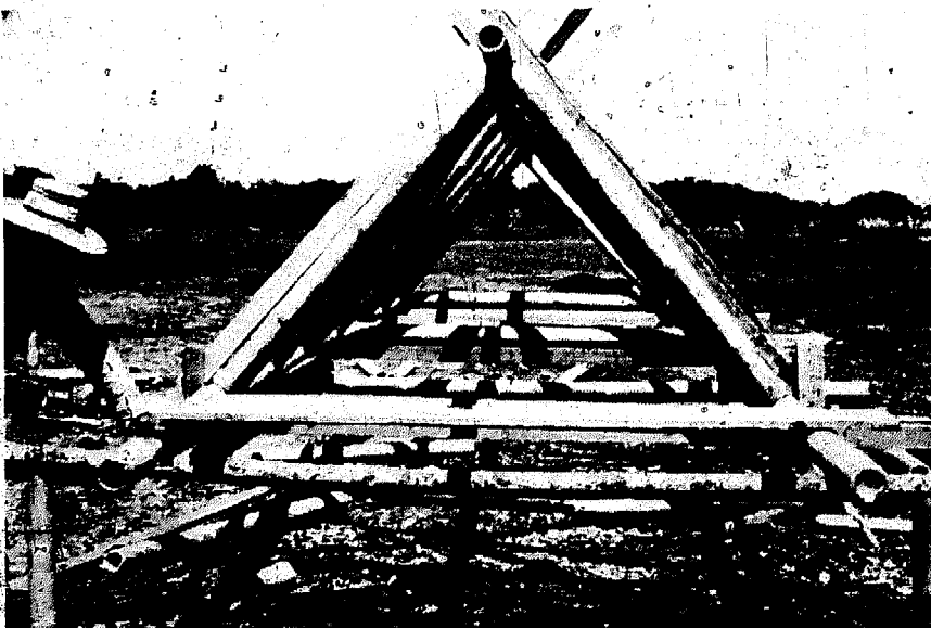
Figura 3-2. Construcción de la armadura sobre soportes horizontales.
