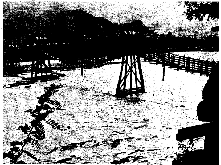
Figura 1-35. Puente colgante con cables de bambú construido sobre el río Min en China. Tiene una longitud aproximada de 225 metros y es el más largo que se conoce en su tipo. Los cables de bambú utilizados en la construcción de puentes colgantes llegaban a tener hasta 30 centímetros de diámetro.
