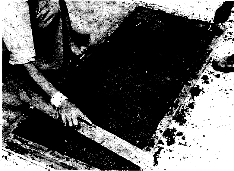
Figura 4-34 El material sobrante se saca con una regla a la vez que se nivela la superficie.
