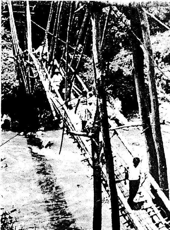
Figura 1-36. En Colombia los únicos constructores de puentes atirantados de guadua son los indios Páez del sur del país. Aunque su estructura es similar a los de Java y Borneo, su acabado es muy rústico.
