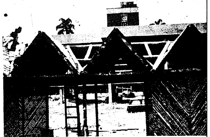
Figura 3-17. Construcción del sobretecho.
