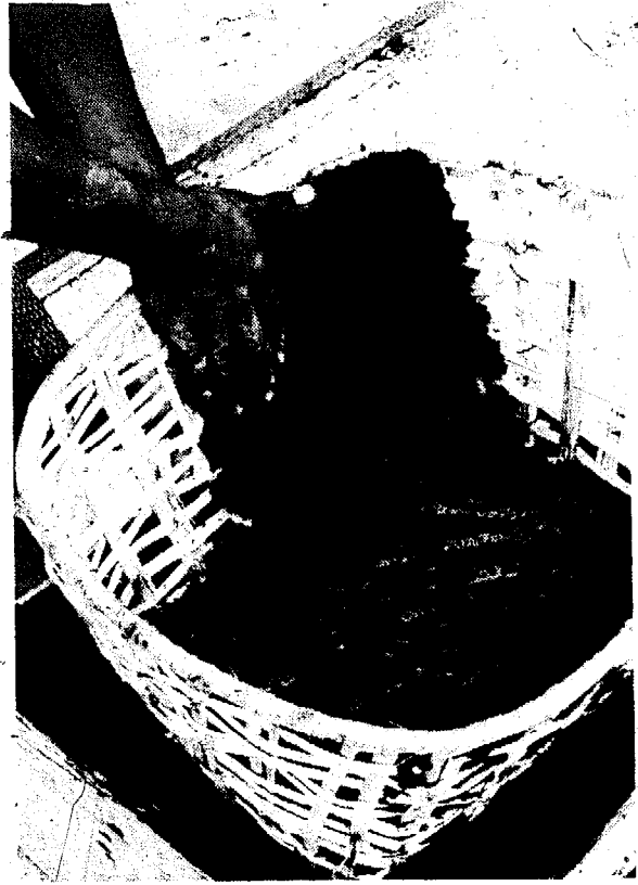
Figura 4-21. Luego se recubre con mortero el lado interior.
