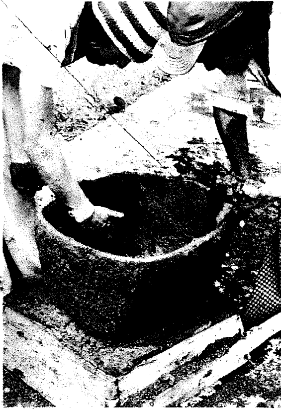
Figura 4-24. Aplicación de la segunda capa interna.
