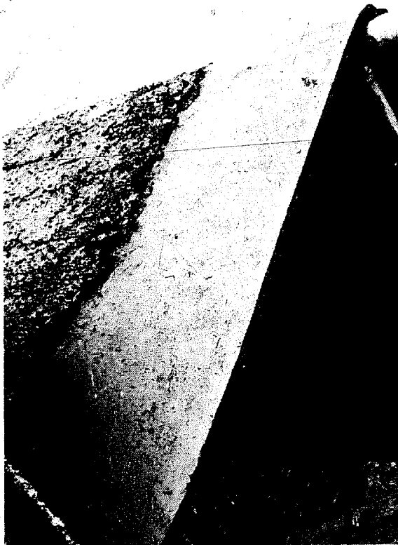
Figura 3-33. La aplicación del mortero debe hacerse en fajas verticales.
