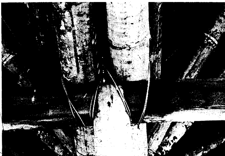
Figura 3-14. Las armaduras se amarran a las vigas principales con doble amarra de alambre No. 12.
