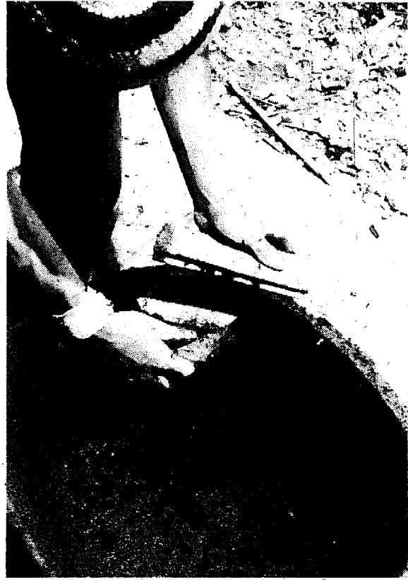
Figura 4-25 Terminación de los bordes.
