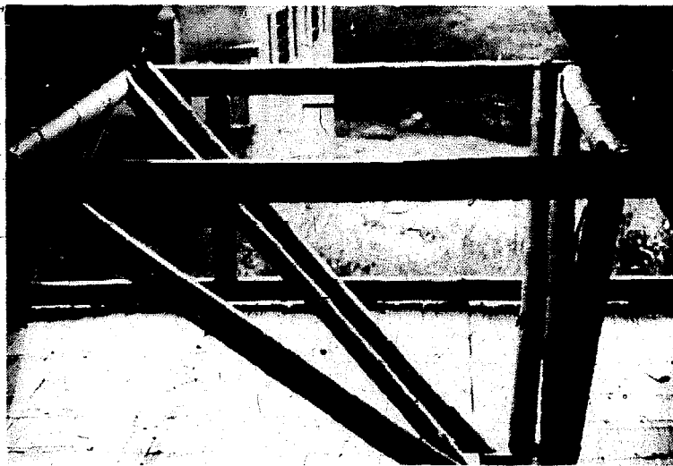
Figura 2-24. Construcción de la tolva. La tolva está formada por un marco superior que descansa sobre soportes verticales y por piezas diagonales que unen sus vértices con los del rectángulo que forma la salida de la misma.
