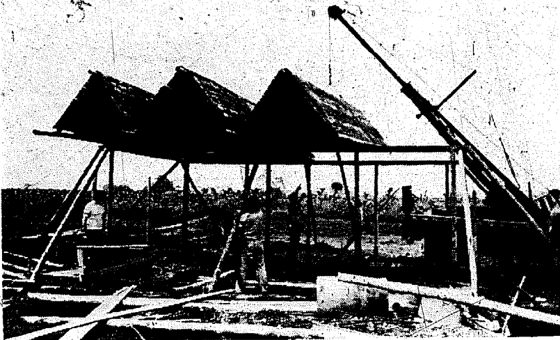
Figura 3-12. Colocación de la tercera armadura.
