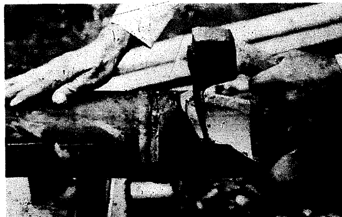
Figura 2-5A. Los empalmes pueden hacerse con ayuda de un serrucho, de una segueta, un machete, o de una azuela como se muestra en la figura.
