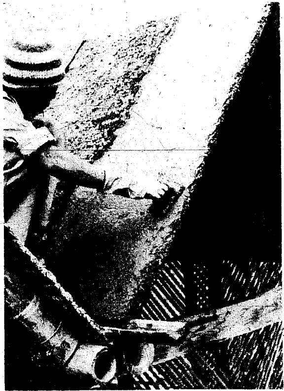
Figura 3-30 Posteriormente se alisa con una yana de madera.
