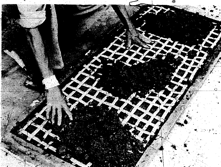
Figura 4-33 Colocación de la capa superior de mortero.
