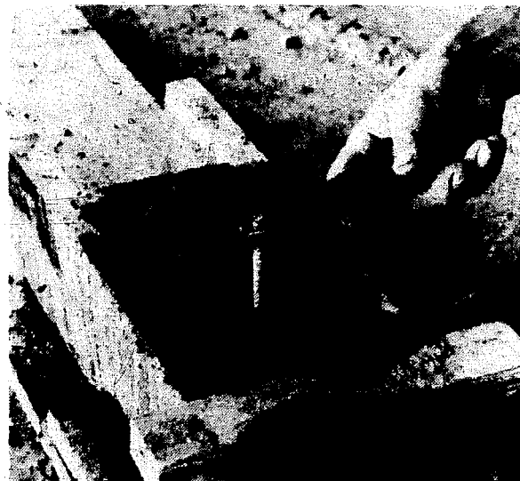
Figura 5-48. Las perforaciones de los postes se hacen dejando varillas de acero o de bambú de 1/4 de pulgada, empapadas con aceite quemado, que luego se sacan a las 8 horas de fundidos los postes.
