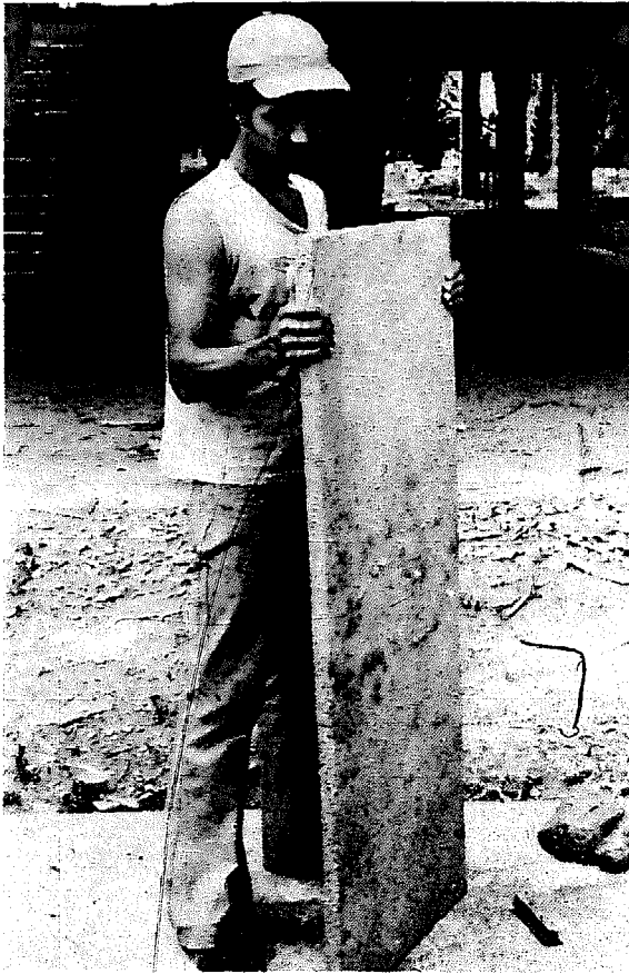
Figura 4-37. Las plaquetas deben hacerse de dimensiones apropiadas para facilitar su transporte.
