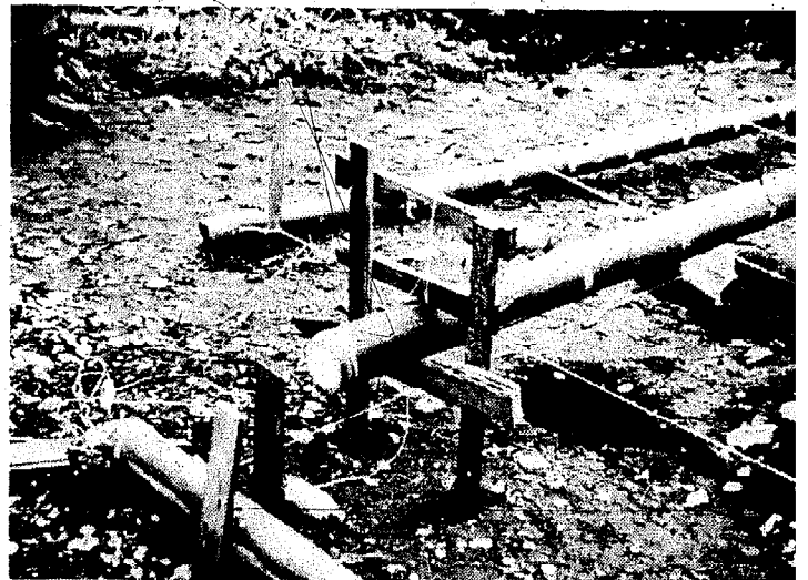
Figura 2-12. Forma de sujetar las piezas No. 2 una vez niveladas por su parte superior.
