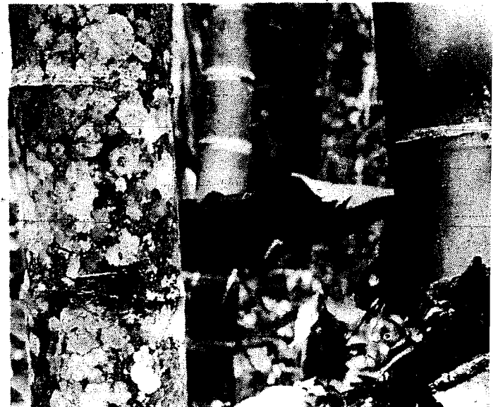
Figura 1-25. En primer plano se observa una guadua madura mayor de 5 años, y una guadua joven de un año. Las guaduas maduras tienen una mayor resistencia a la compresión y por ello son las más apropiadas para utilizar en construcción.
