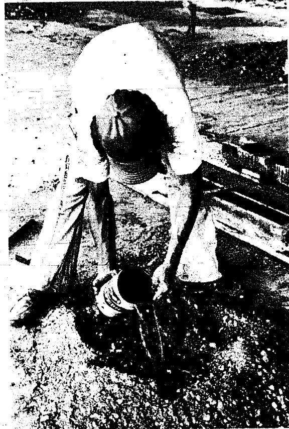
Figura 4-4. Para medir el agua se puede emplear también un tarro de galletas, diferente al utilizado para medir el cemento y la arena.
