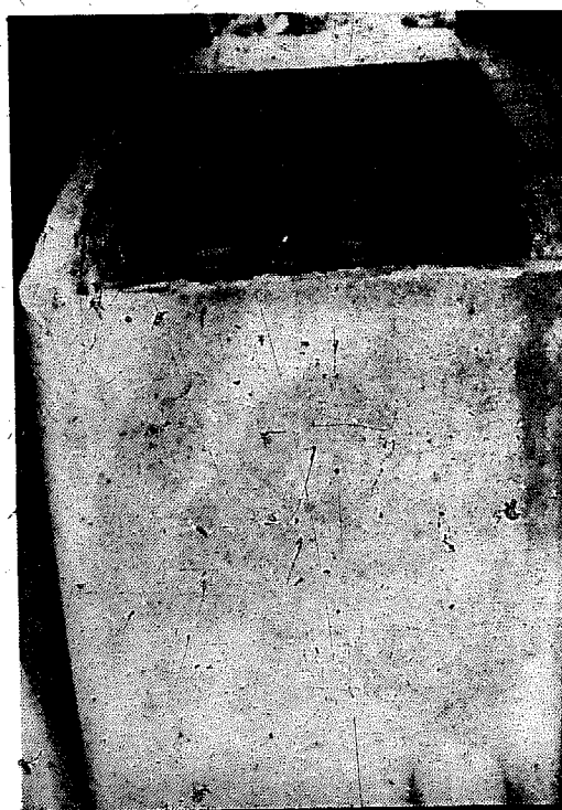
Figura 4-9 Recubrimiento exterior terminado.
