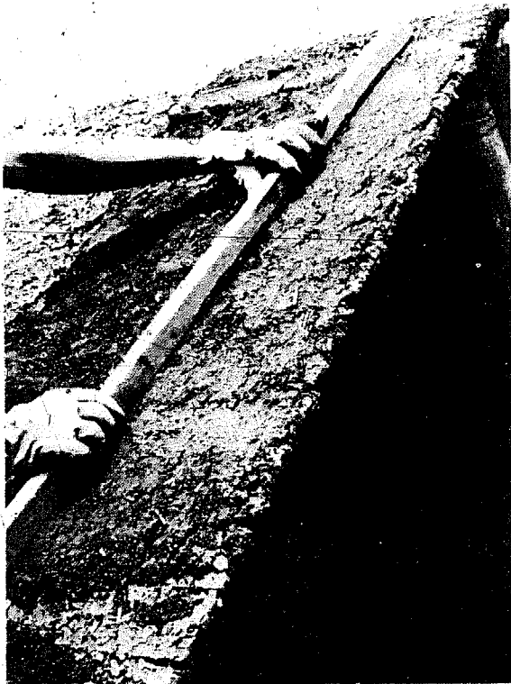
Figura 3-29. Para nivelar y sacar el exceso de material se pasa una regla.
