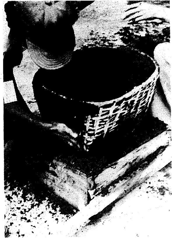
Figura 4-23 Dos o tres días después se recubre exteriormente con la primera capa y se aplica interiormente la segunda o final.
