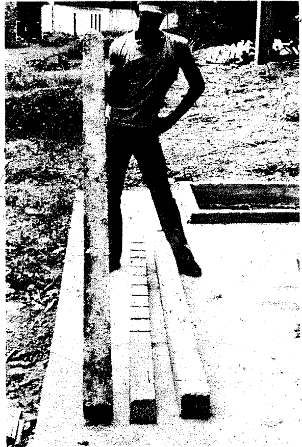
Figura 5-49. Las formaletas pueden quitarse dos días después de fundidos los postes. Estos deben humedecerse dos veces al día durante una semana para lograr un buen curado. Los postes sólo pueden utilizarse 4 semanas después de fundidos.
