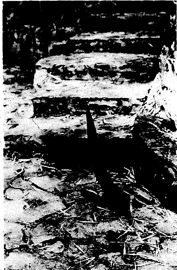
Figura 1-10. El crecimiento de la guadua o de cualquier otro bambú, es tan vigoroso que puede levantar hasta un piso de piedra como el que se muestra en la figura.
