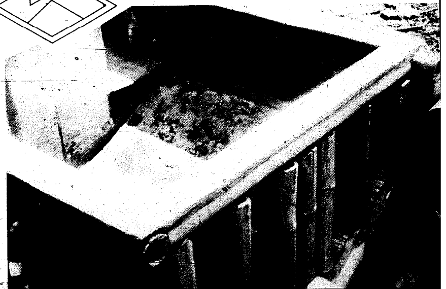
Figura 2-27. El escurrido puede construirse con esterilla en la forma como se indica en la figura o utilizando la técnica del bambú-cemento que se indica en otra parte de esta publicación.
