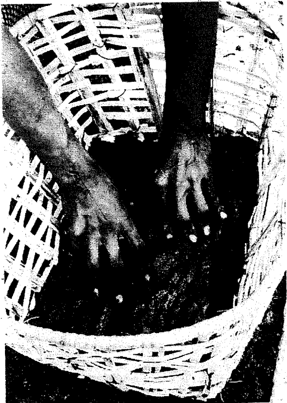
Figura 4-20 La capa de mortero se presiona con los dedos sobre la anterior.
