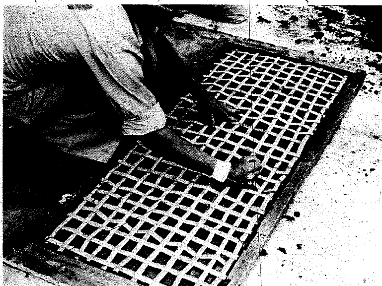
Figura 4-32 La malla se comprime contra el mortero.
