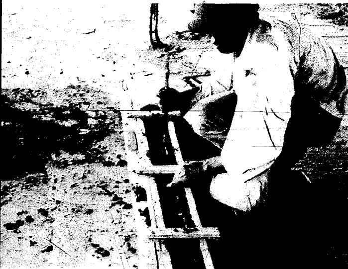
Figura 5-47. Al vaciar el concreto dentro de la formaleta, éste debe "chuzarse" con el fin de que el concreto cubra completamente el refuerzo y para que no queden "hormigueos" o zonas sin fundir.
