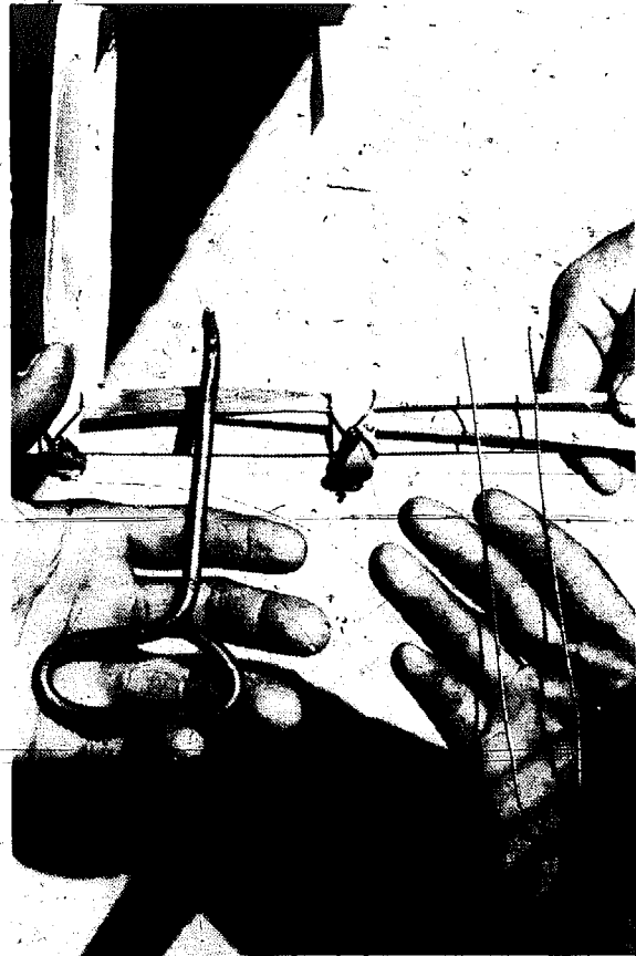
Figura 5-27. Colocación del alambre para iniciar el amarre.
