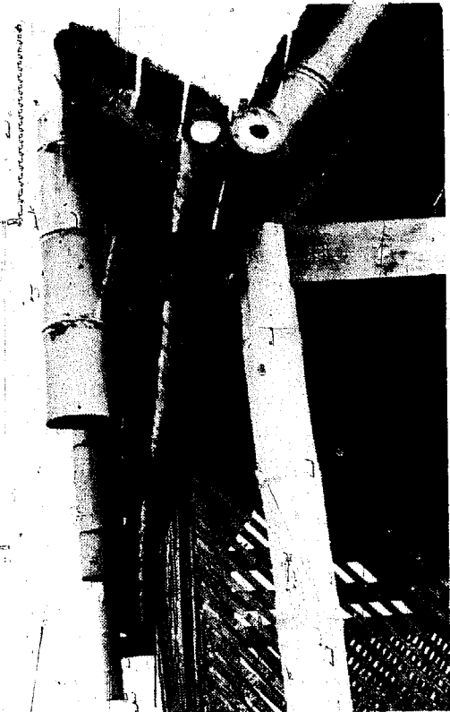
Figura 3-19. Colocación del alero y soportes del mismo.
