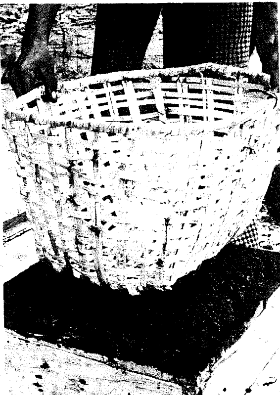
Figura 4-18. La canasta, saturada de agua, se coloca sobre la capa de mortero extendida, y se presiona para que el mortero salga entre las cintas.
