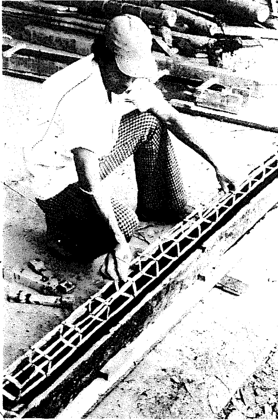
Figura 5-45. La armadura se debe hacer 5 centímetros más corta que la longitud real o total del poste.
