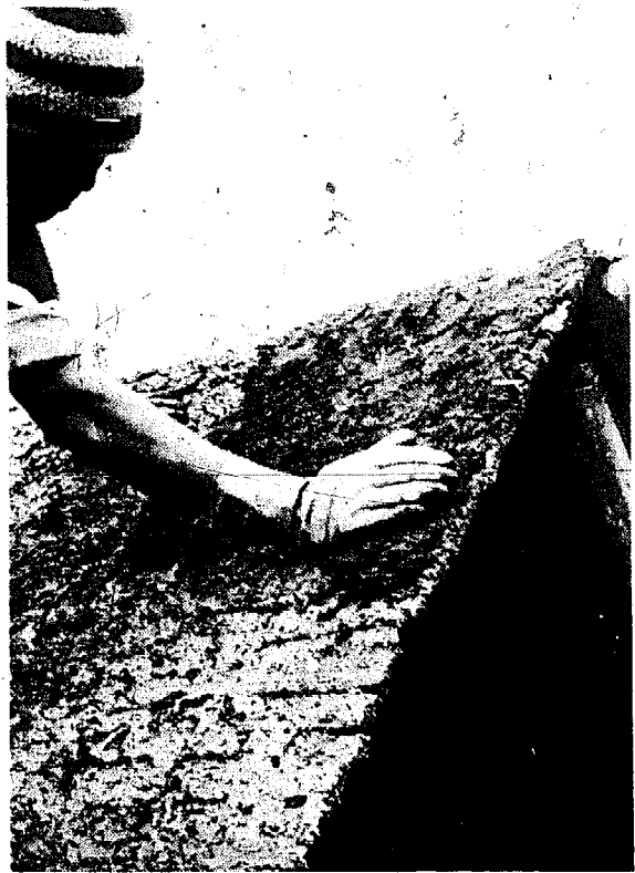
Figura 3-28. El mortero ya preparado se aplica presionándolo sobre la cubierta.
