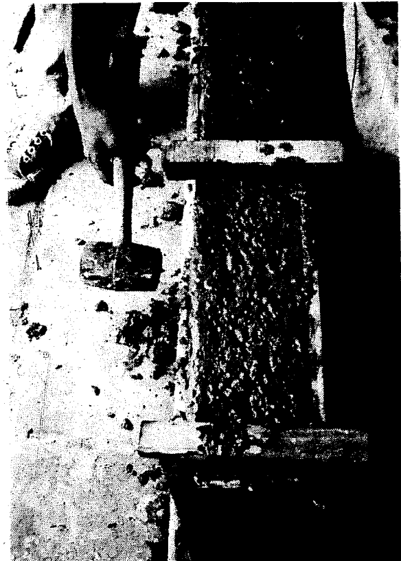
Figura 5-36. Para lograr una distribución pareja del concreto en la viga, la formaleta se golpea exteriormente con un martillo de caucho u otro elemento similar.
