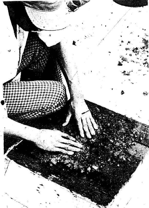
Figura 4-17. Sobre la base se extiende una capa de mortero nivelada con la mano.
