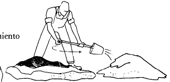
Worker mixing cement and sand Operario mezclando el cemento y arena
