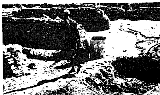
FIGURE 155 : LA TERRE EST PETRIE EN FORME DE BOULE
