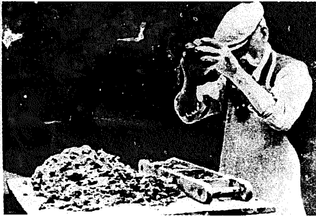
FIGURE 167 : MOULAGE « A LA BALLE » SUR TABLE (ALLEMAGNE DE L'EST)
