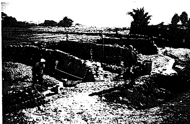
FIGURE 154 : LA TERRE EST TRANSPORTEE A L'AIDE DE COUFFES RECTANGULAIRES TRESSEES AVEC DES FEUILLES DE PALMIER
