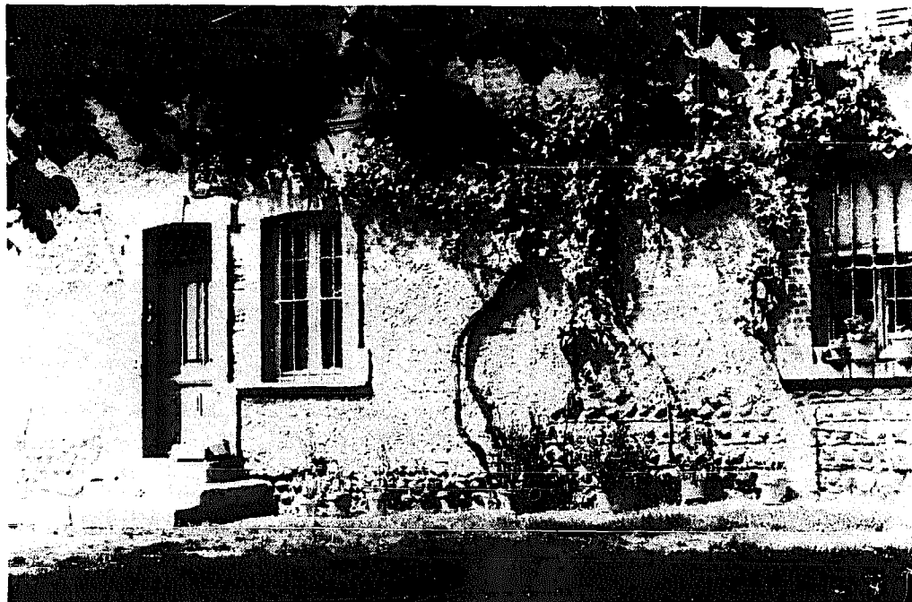
FIGURE 47 : FAÇADE DE LA PARTIE HABITATION
