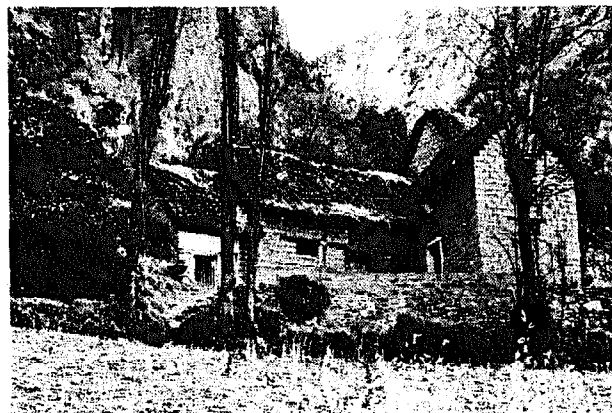
FIGURE 161 : LE TOIT EST EN CHAUME D'ICHU SERVANT ÉGALEMENT A FABRIQUER L'ADOBE (PEROU)
