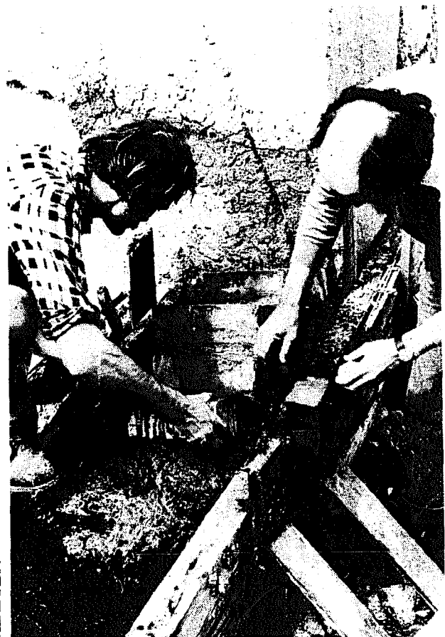
FIGURE 311 : POSE DES PREMIERES BRIQUES SUR LE SOUBASSEMENT
