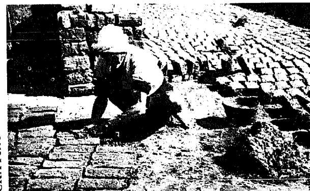
FIGURE 158 : LE MOULE EST RETIRE ET ON RECOMMENCE UNE NOUVELLE BRIQUE
