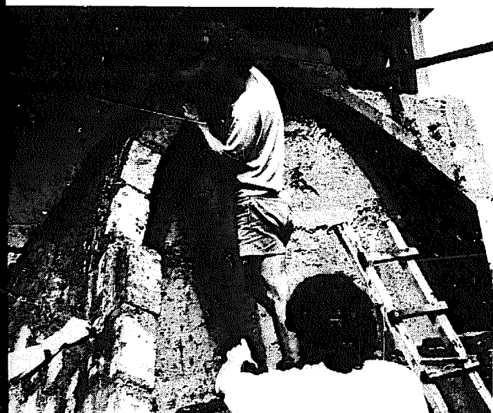
FIGURE 313 : LES BRIQUES DU SOMMET SONT LES PLUS DÉLICATES À POSER
