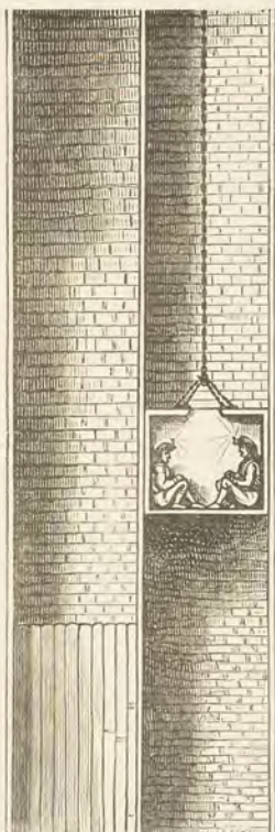
DESCENDING THE PIT.
