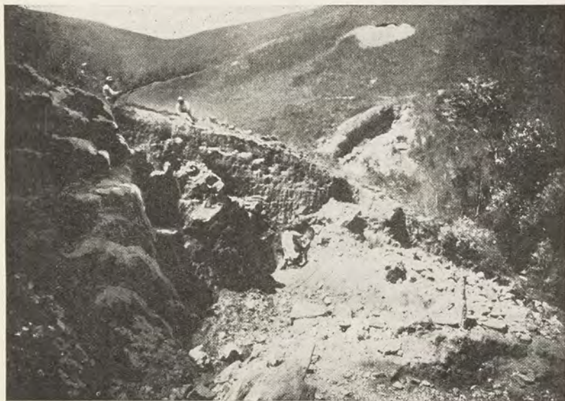
Tranchée à Antsangombato
