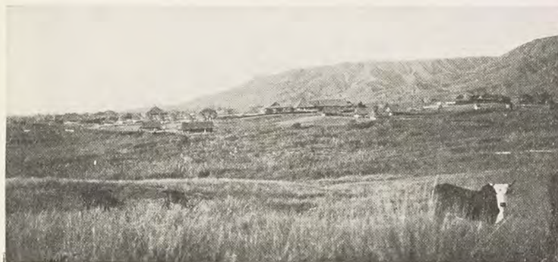
Le poste d'Ambatomainy
