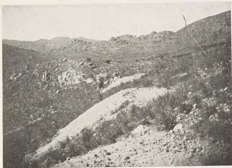
Travaux de Tongafeno
