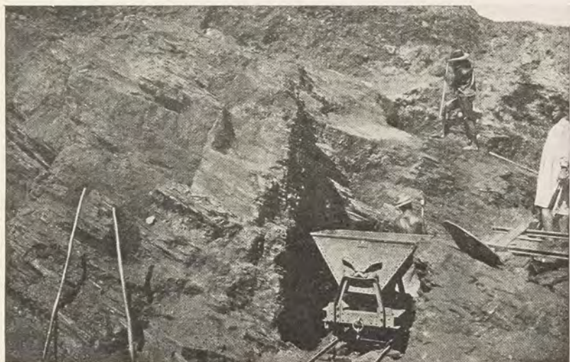
Travaux de Tsimivolovolo
