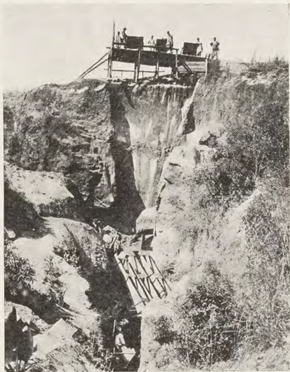
Travaux de Tsimivolovolo
