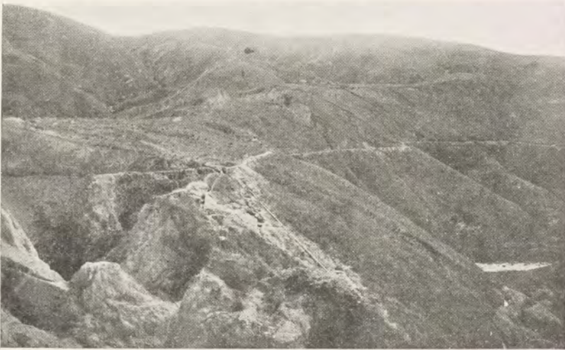
Travaux de M. Robert, à Antanifotsy
