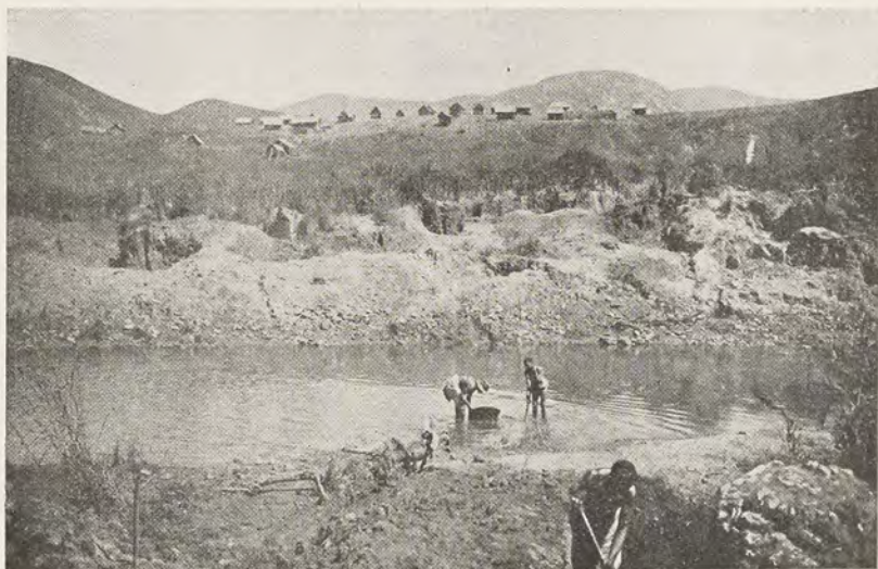
Travaux et camp d'Ialamalaza
