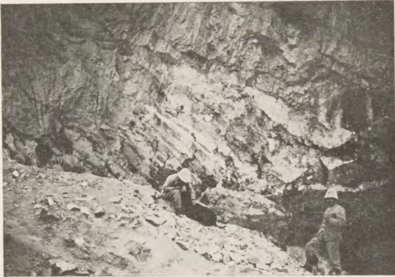
Travaux de Vahinambo
