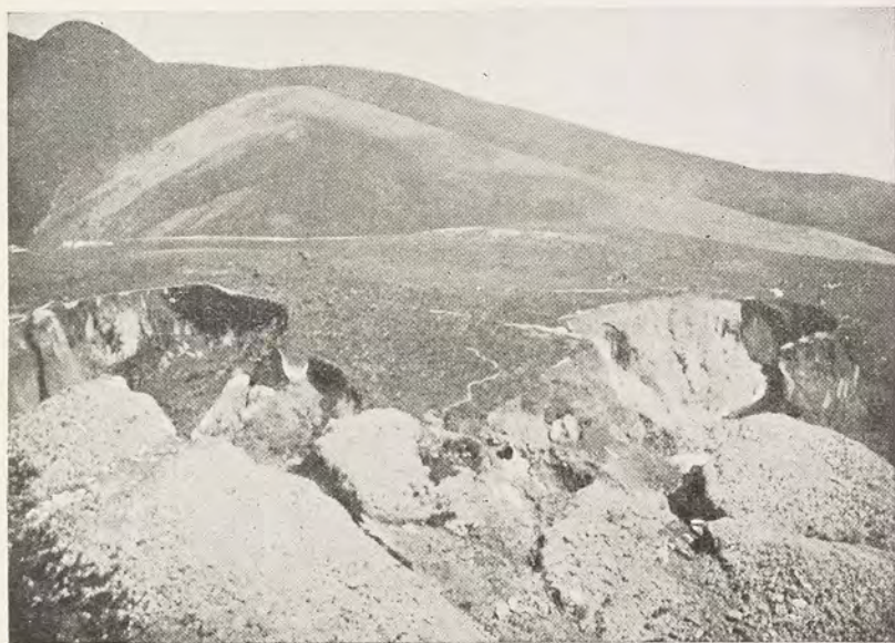
Travaux de Tongafeno
