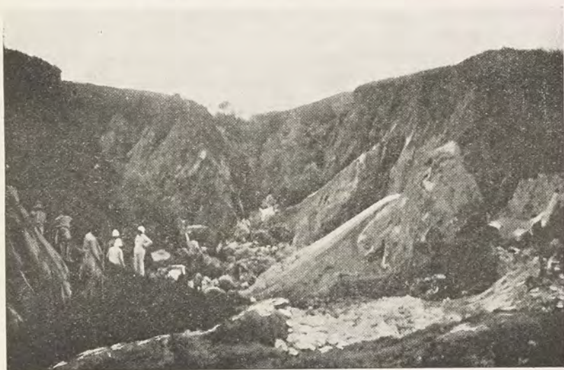
Tranchée à Maharitra, dans la pegmatite gemmifère
