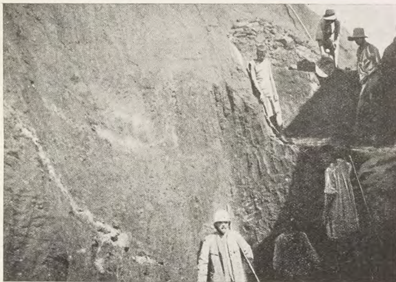
Tranchée à Ambatoboka
