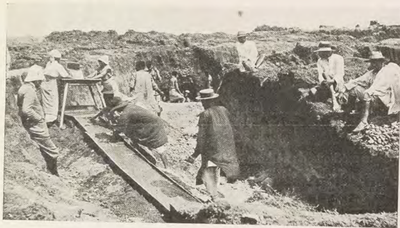
Lavage au sluice, à Tsimivolovolo
