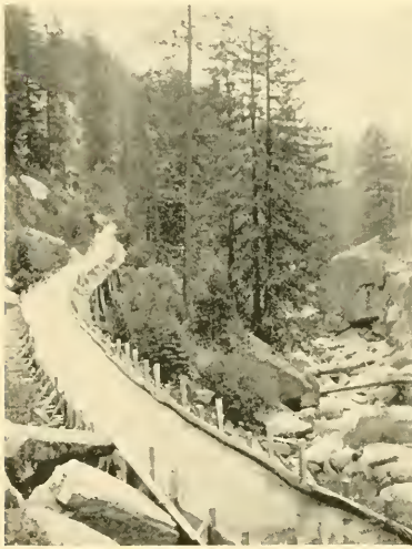
A FLUME OF THE TUOLUMNE WATER CO.
