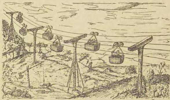
Le wagonnet chargé circule sur un câble en acier de 0<sup>m</sup>,031 de diamètre et de 2200 mètres de longueur ; arrivé à la gare, il est
