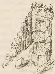
Fig. 130. Bergvägg på Billingen visande quaderformig förklyftning.
