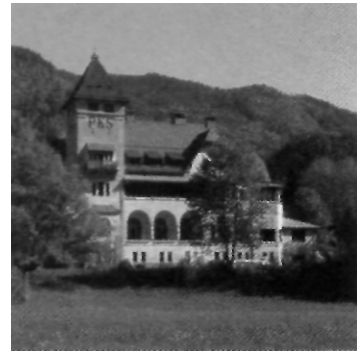
Fig. A. 1. The Pythagoras Kepler School at Engleithen.
