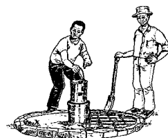
Coloque el alambre de refuerzo y un molde para el hueco.
