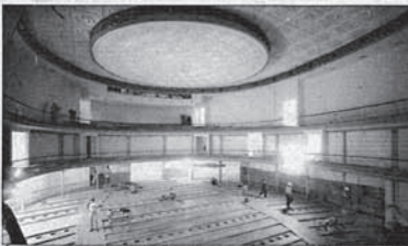
Últimos retoques - Operários trabalham na restauração do Teatro São Paulo, na Barra Funda. Fig. C1
