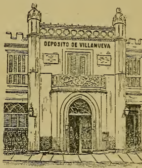
No. 15.—JUNTA DE FOMENTO. Estación del Ferrocarril de la Habana.
