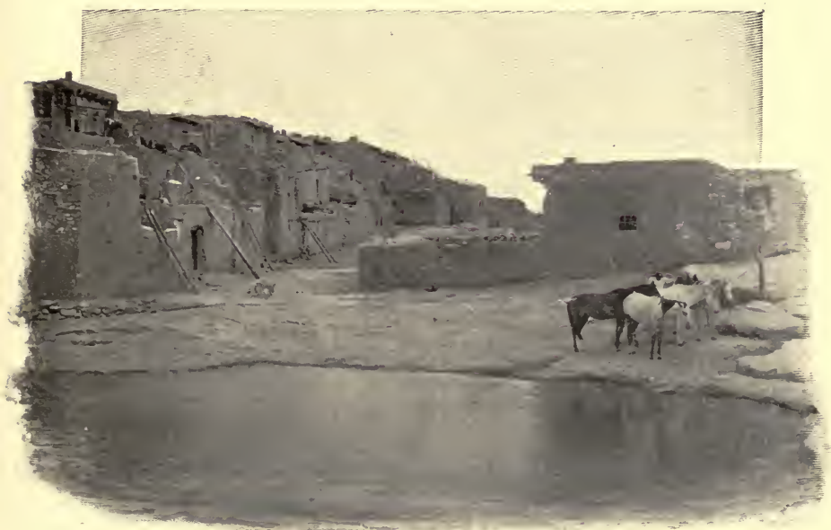
RAIN WATER BASIN, ÁCOMA.
