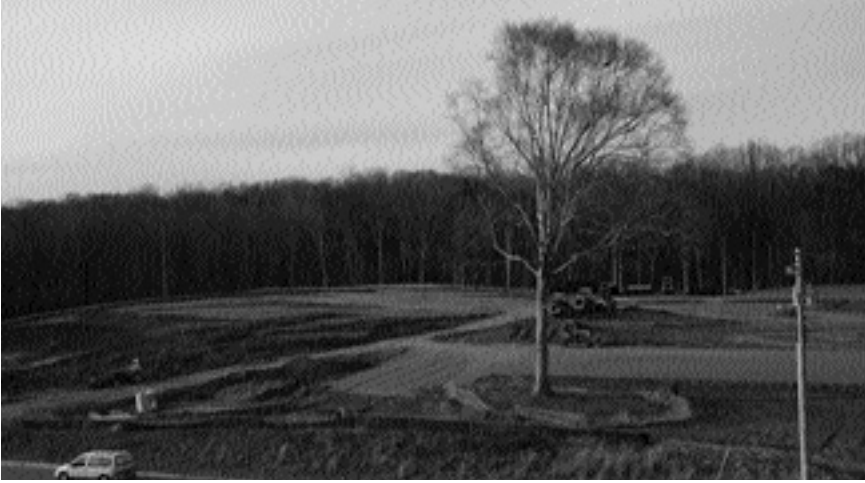
Site prep, Annapolis.
