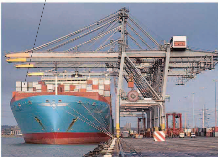
el muelle comercial | containerport
