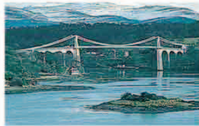
el puente bridge
