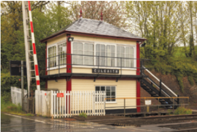
signal box 铁路信号房 tiě lù xìn hào fáng
