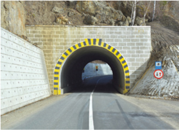
tunnel 隧道 suì dào
