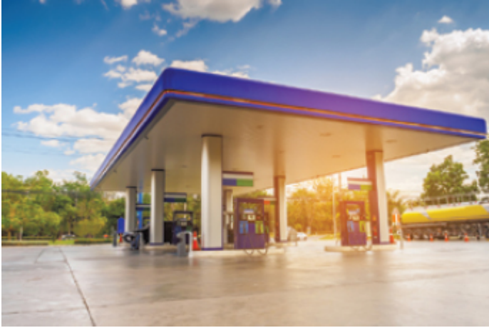
petrol station 加油站 jiā yóu zhàn
