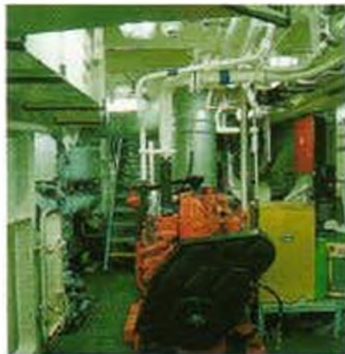
engine room • la salle des moteurs • der Maschinenraum • la sala de máquinas • la sala macchine
