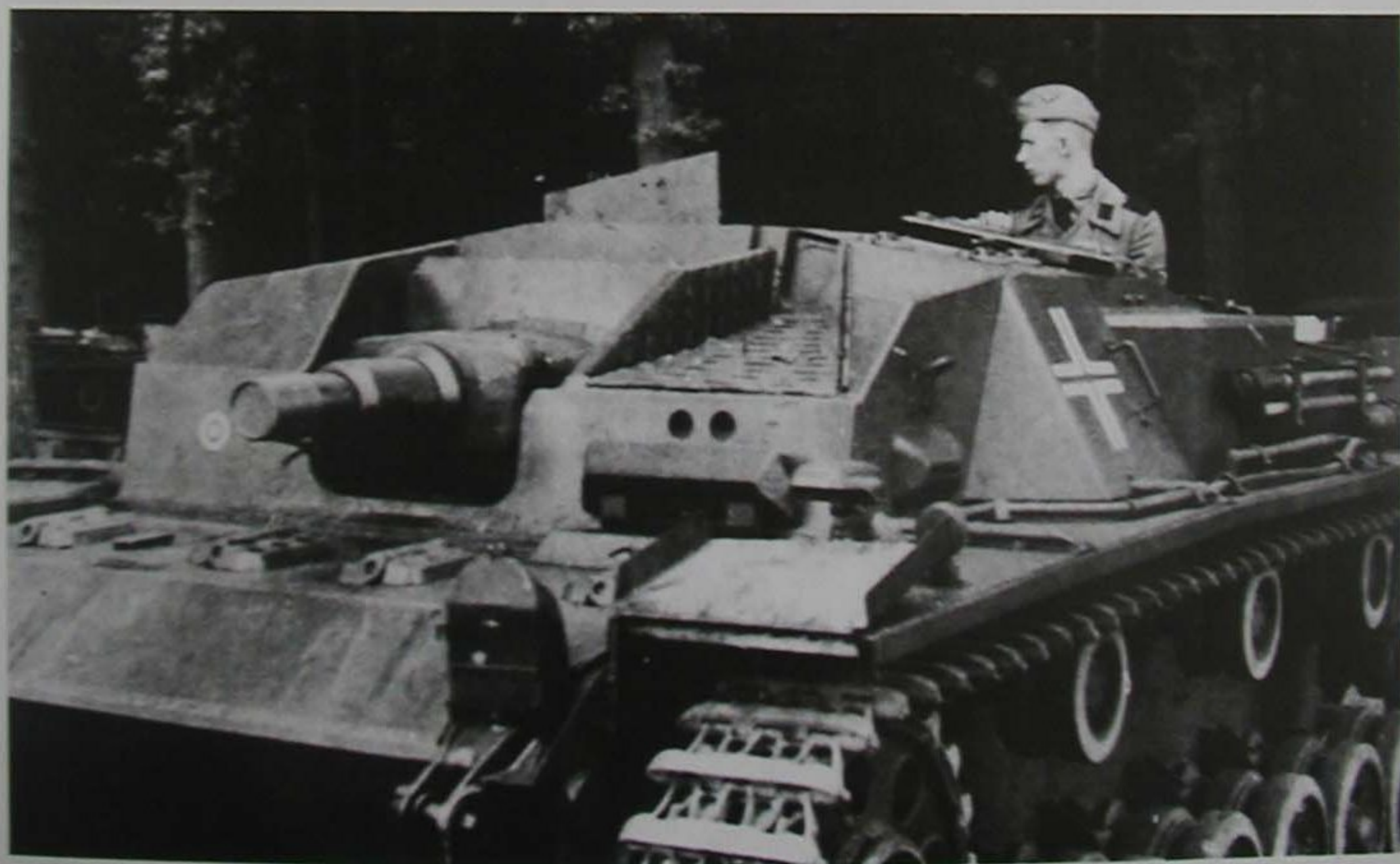
Działo szturmowe StuG III Sd Kfz 142 Ausf. A ze StuG Batterie brygady „ LSSAH ”, Francja, czerwiec 1940 roku. Widoczne białe, kółko – oznaczenie taktyczne jednostki namalowane na pancerzu czołowym. A StuG III Sd Kfz 142 Ausf. A assault gun of the StuG Batterie of the SS-Brigade “LAH” in France in June 1940. Note white circle tactical sign painted on the front armour. [Tank Museum]
