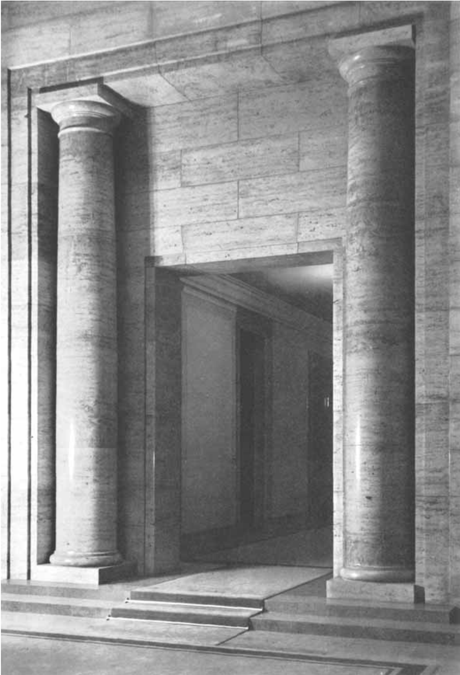
ÖSTLICHER VERWALTUNGSBAU, FLURMÜNDUNG
