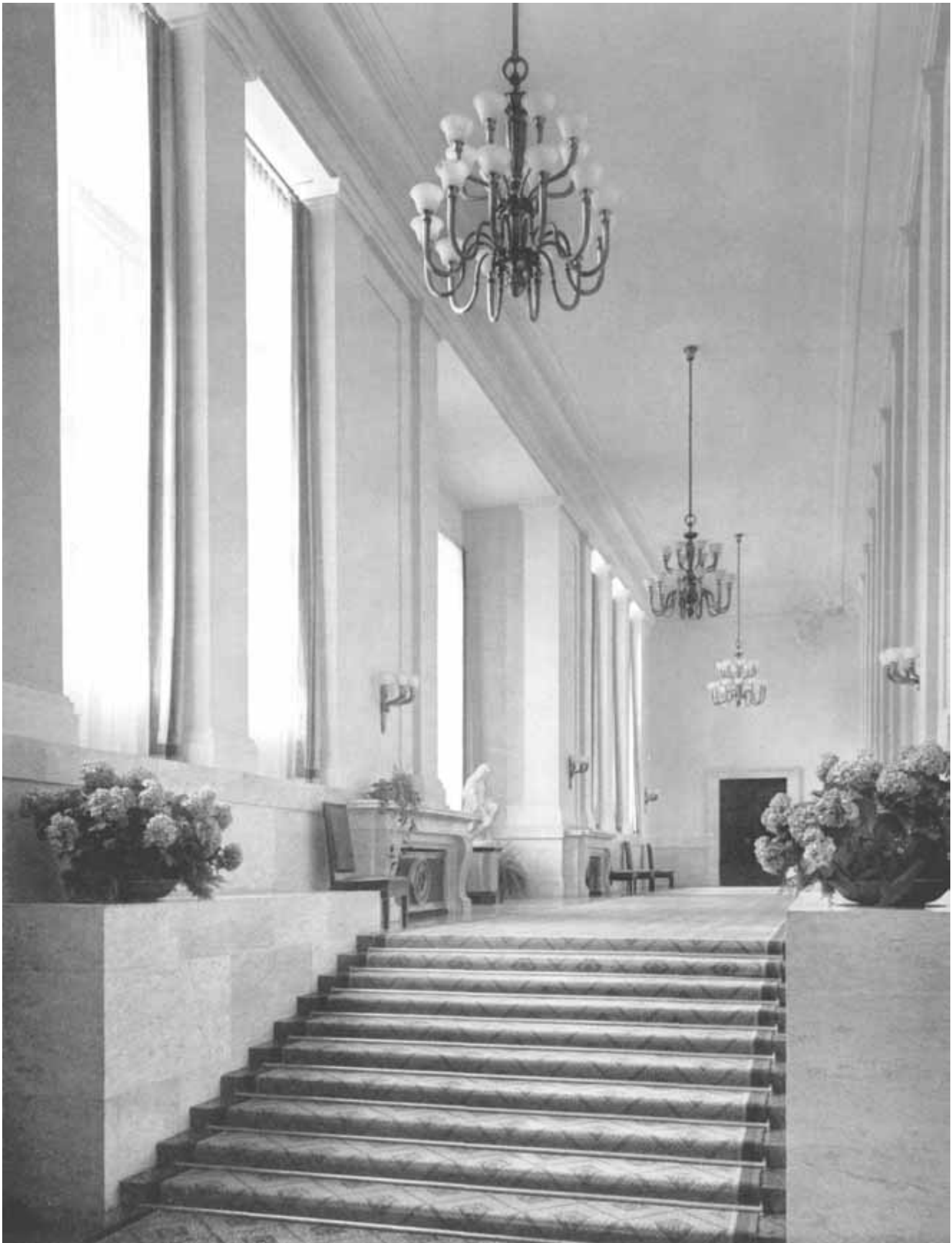
VERBINDUNGSGANG ZWISCHEN DER NEUEN REICHKANZLEI UND DER WOHNUNG DES FÜHRERS • ENTW.: C. PINNAU
