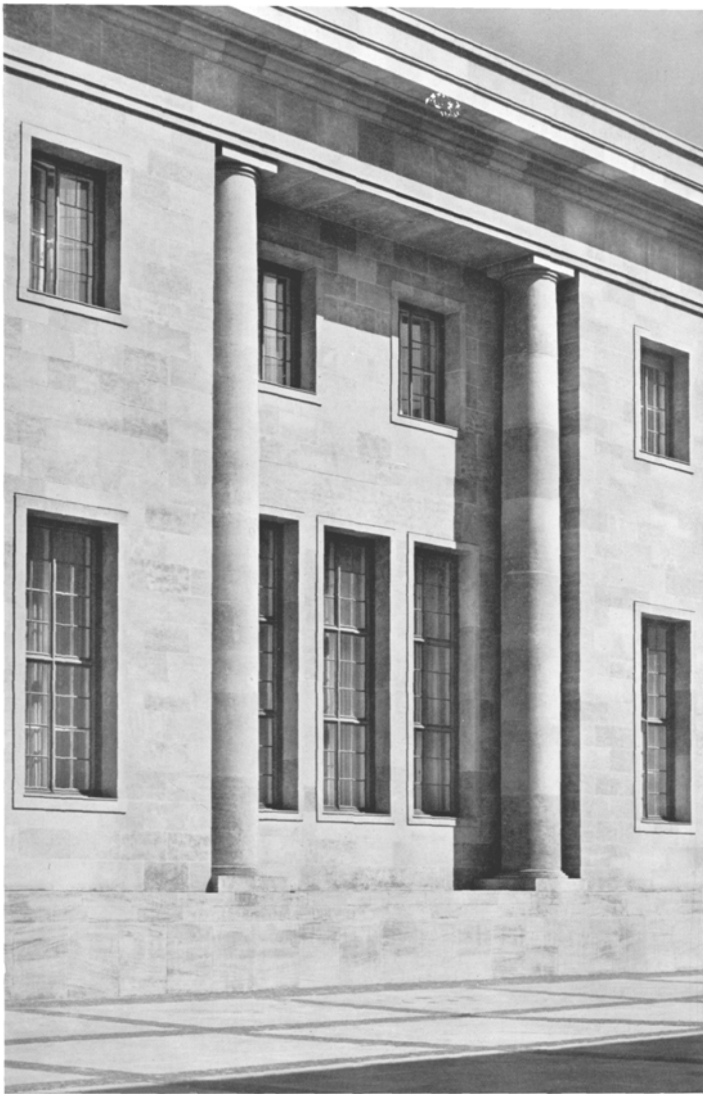
EHRENHOF, TEILANSICHT DER NORDWAND
