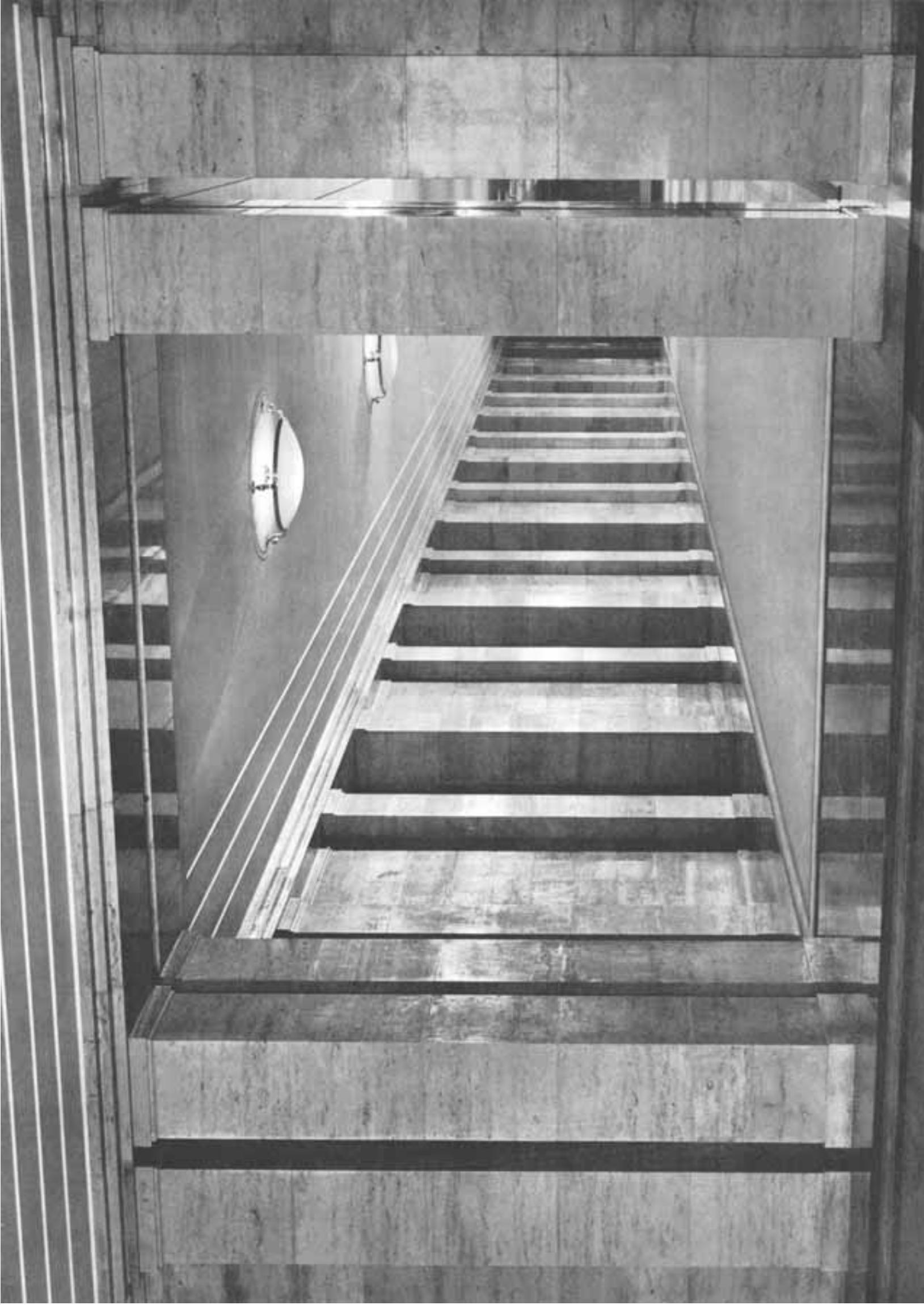
VERBINDUNGSHALLEN IM WESTLICHEN VERWALTUNGSBAU (VOSS-STRASSE 6)
