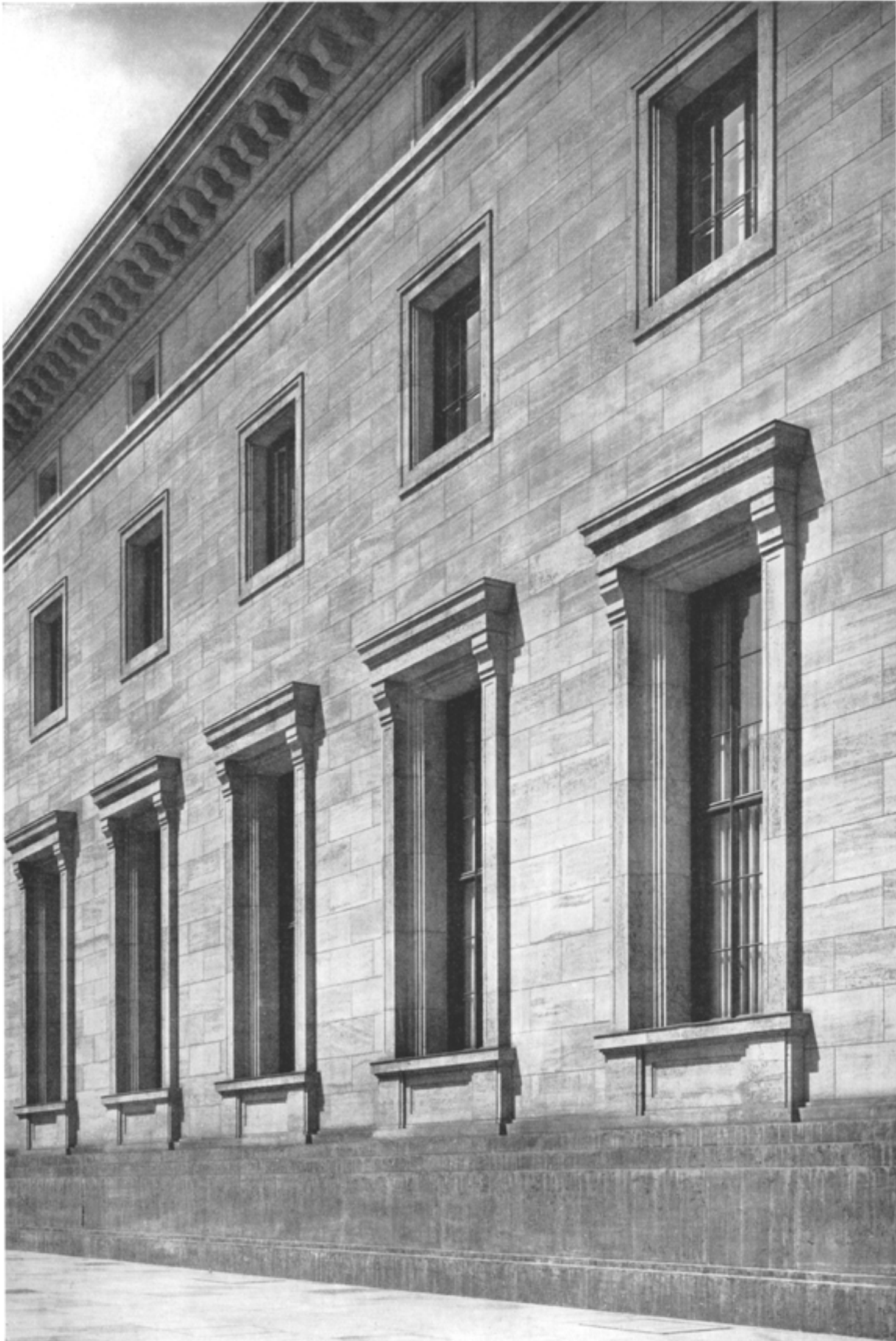
TEILANSICHT VOSS-STRASSE, MITTELBAU
