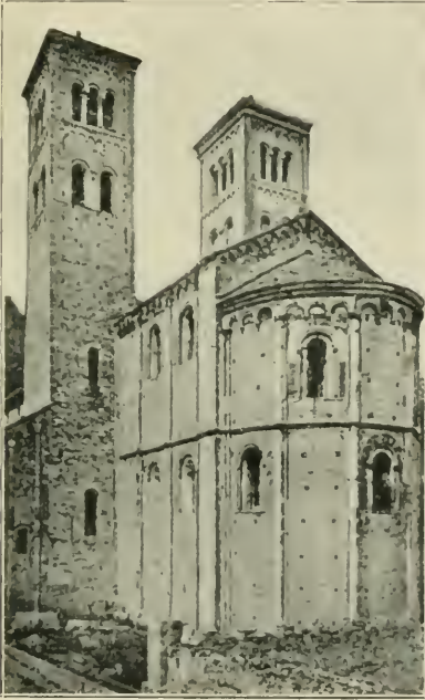
CHURCH OF S. ABBONDIO, COMO.
