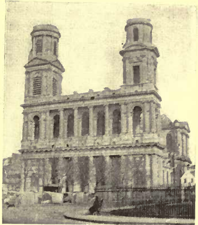
FIG. 188.—FAÇADE OF ST. SULPICE, PARIS.
