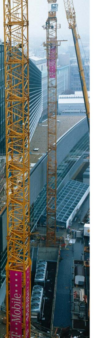
Die Fassade am Hohen Flügel stellte die Herausforderung, nach außen überhängende Elemente mit zueinander schiefwinkligen Verschneidungen an den Kanten passgenau zu planen und zu montieren. Sämtliche Arbeiten an den Hauptfassaden erfolgten ohne Gerüst. The installation of the façade on the high wing presented the challenge to precisely plan and fit the outward projecting elements, forming oblique-angled edges. All work on the main façades was carried out without any scaffolds.
