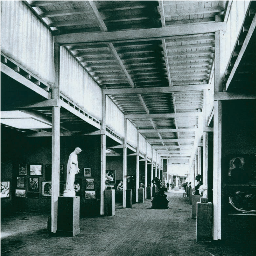
Illustration 10.10 Le Palais de Bois, Porte-Maillot, Paris, France (1924). Architect: Auguste Perret.
