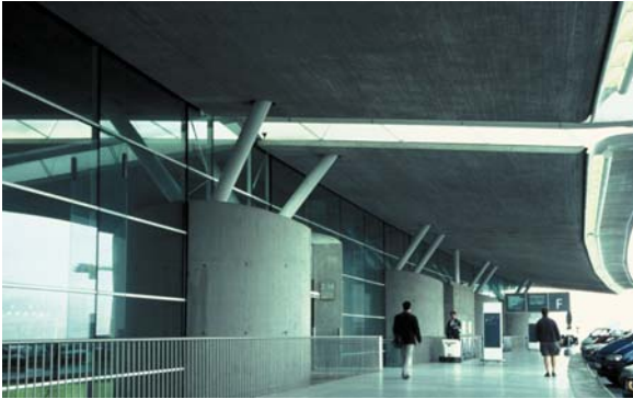
▲ 4.30 Charles de Gaulle Airport: Terminal 2F, Paris, France, Aéroports de Paris, 1999. Semi-circular columns signal entry.
