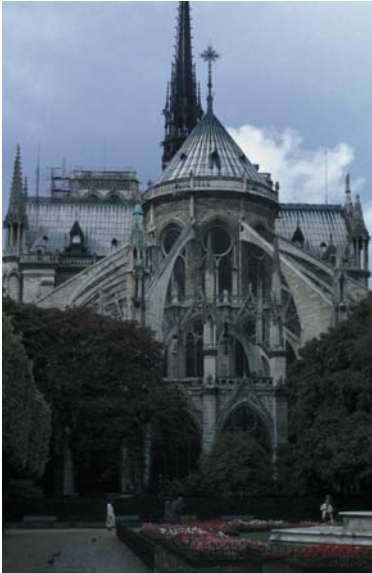
▲ 4.8 Cathédrale Notre Dame, Paris, France, 1260. Deep perimeter structure surrounds the chevet.
