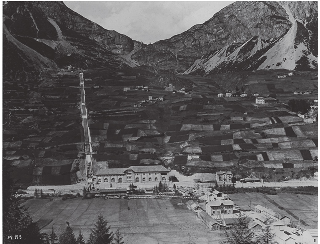
FIGURE 1 Hydroelectric iconeme: slope, penstock, power house. Valdidentro, circa 1930 (Archivio fotografico Fondazione AEM)
