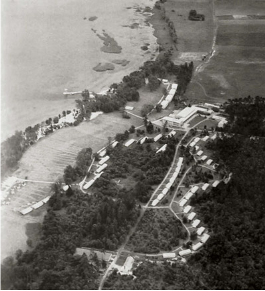
fig. 3 Klink, FDGB-holiday resort Völkerfreundschaft . Source: Architektur und Städtebau der DDR , ed. Dt. Bauakademie (Leipzig: Buch- und Kunstverlag 1969), 62.
