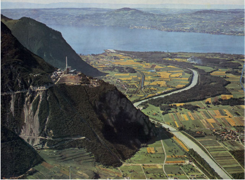
fig. 8 View of the Thermal Power Station of Chavalon-sur-Vouvry, Switzerland, in UIA, Charles-Édouard Geisendorf et al. (eds.), L'Architecte et l'Urbaniste en Face des Grands Travaux de l'Énergie, du Trafic et de l'Assainissement (Lausanne, Bulletin Technique de la Suisse Romande, 1966): 44–45. Image credit: Bulletin Technique de la Suisse Romande . The power station is on the foreground, overlooking the Rhône delta and Lake Geneva on the background.
