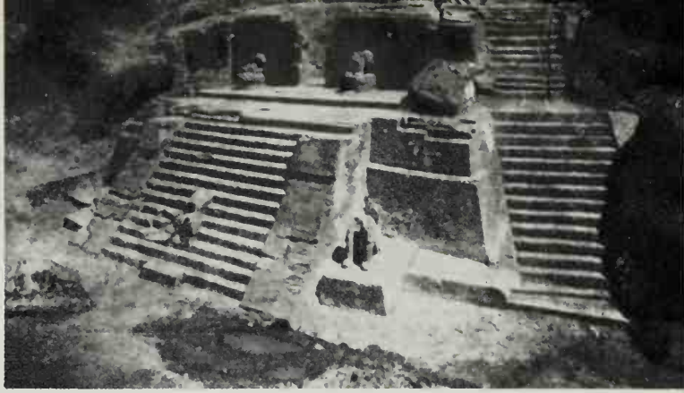
12. Rock-cut temple, Malinalco.
