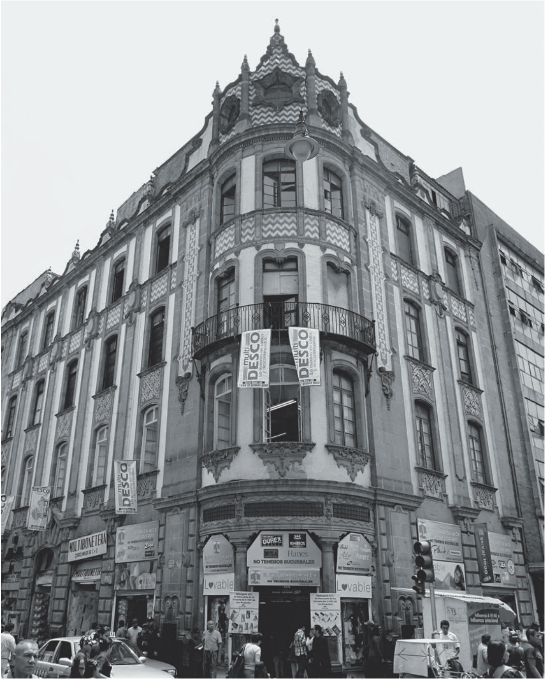
FIGURE 1.11. Federico Mariscal, Edificio Sostres y Dosal, 1917.
