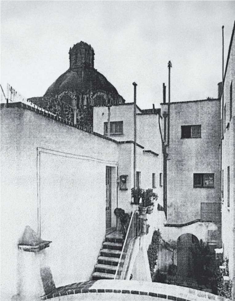
FIGURE 4.6. Obregón Santacilia, Casa de Vecindad, roof, 1926.
