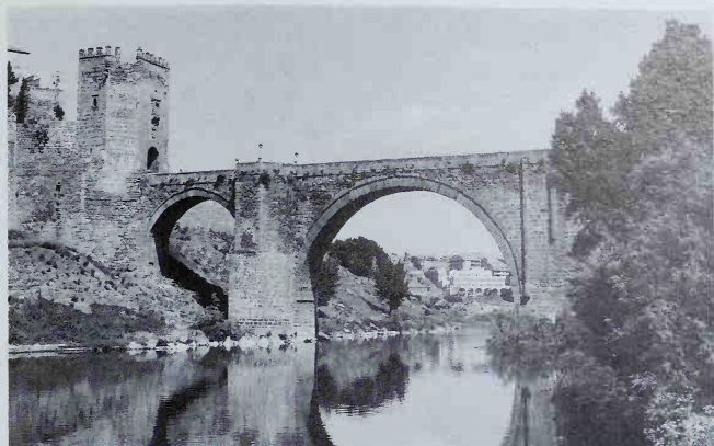
The Puente and Puerta de Alcántara.
