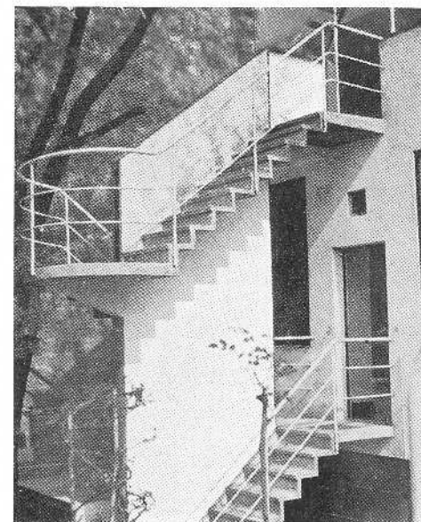
L'escalier dans le jardin
