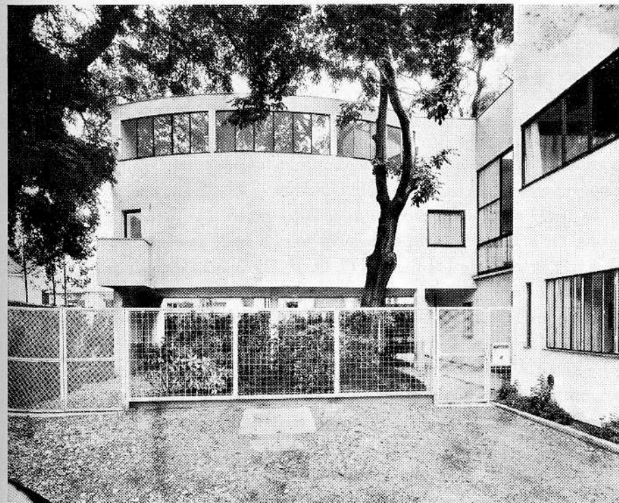
Le pavillon (La Roche)
