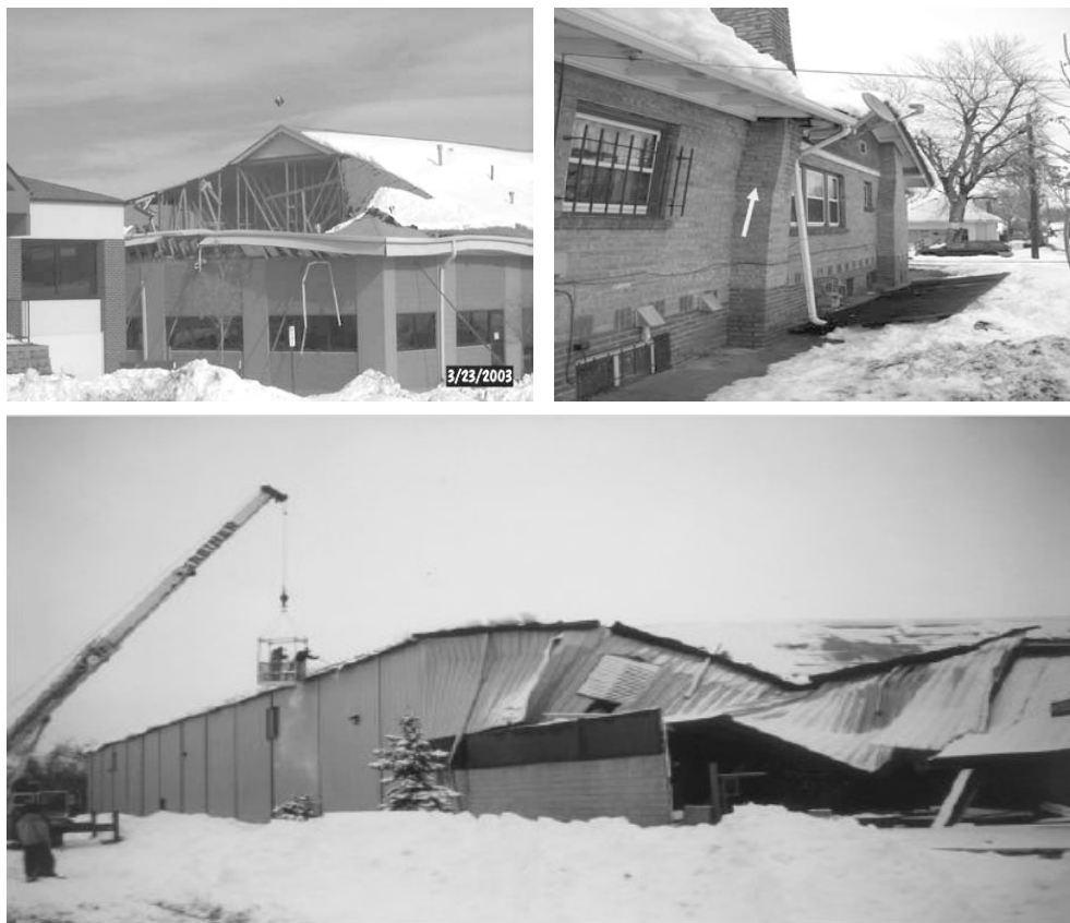
Fig. 3.2. Avarii provocate de acțiunea zăpezii Factorii de care depinde încărcarea din zăpadă sunt:
