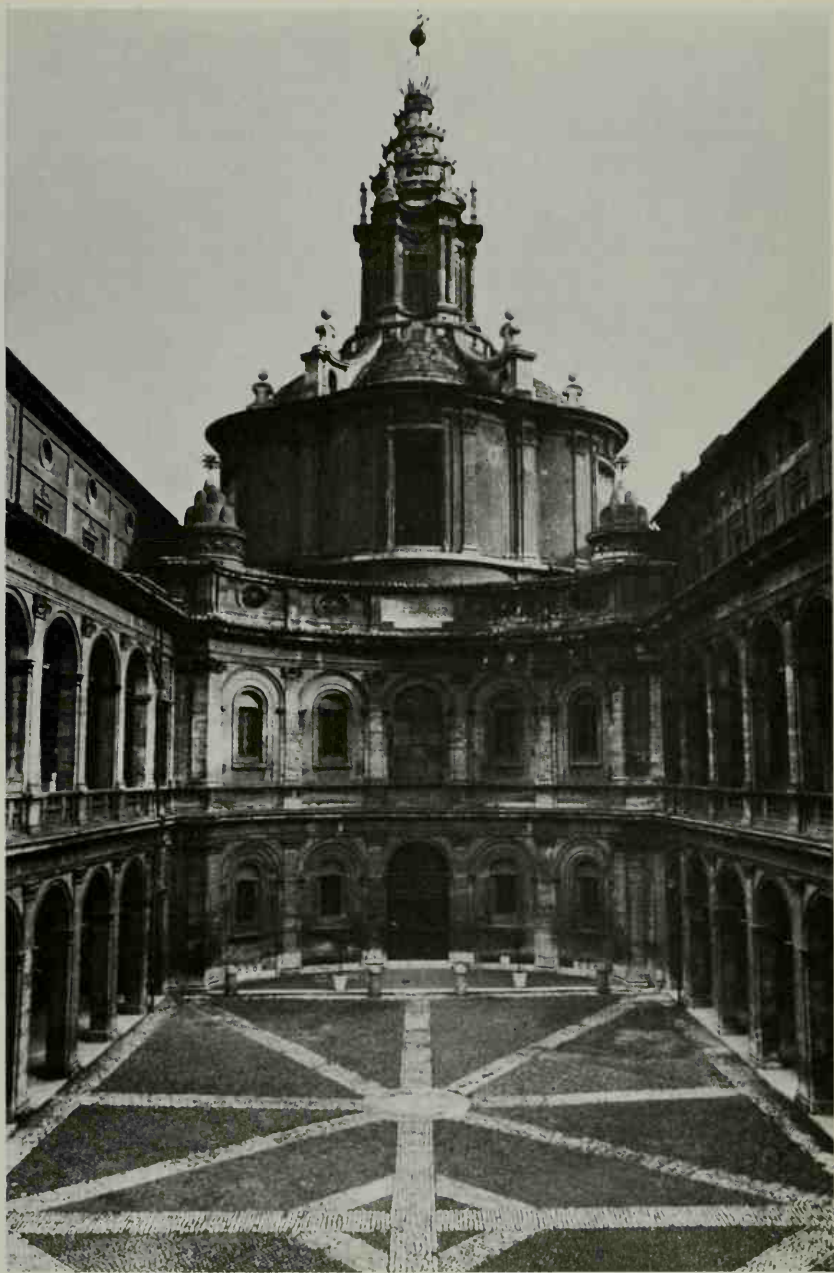
125. Francesco Borromini: Rome, S. Ivo della Sapienza, 1642-50. View from the courtyard
