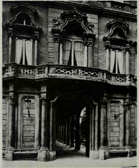
256 ( below, right ). Ferdinando Fuga: Rome, Palazzo della Consulta, 1732-7
