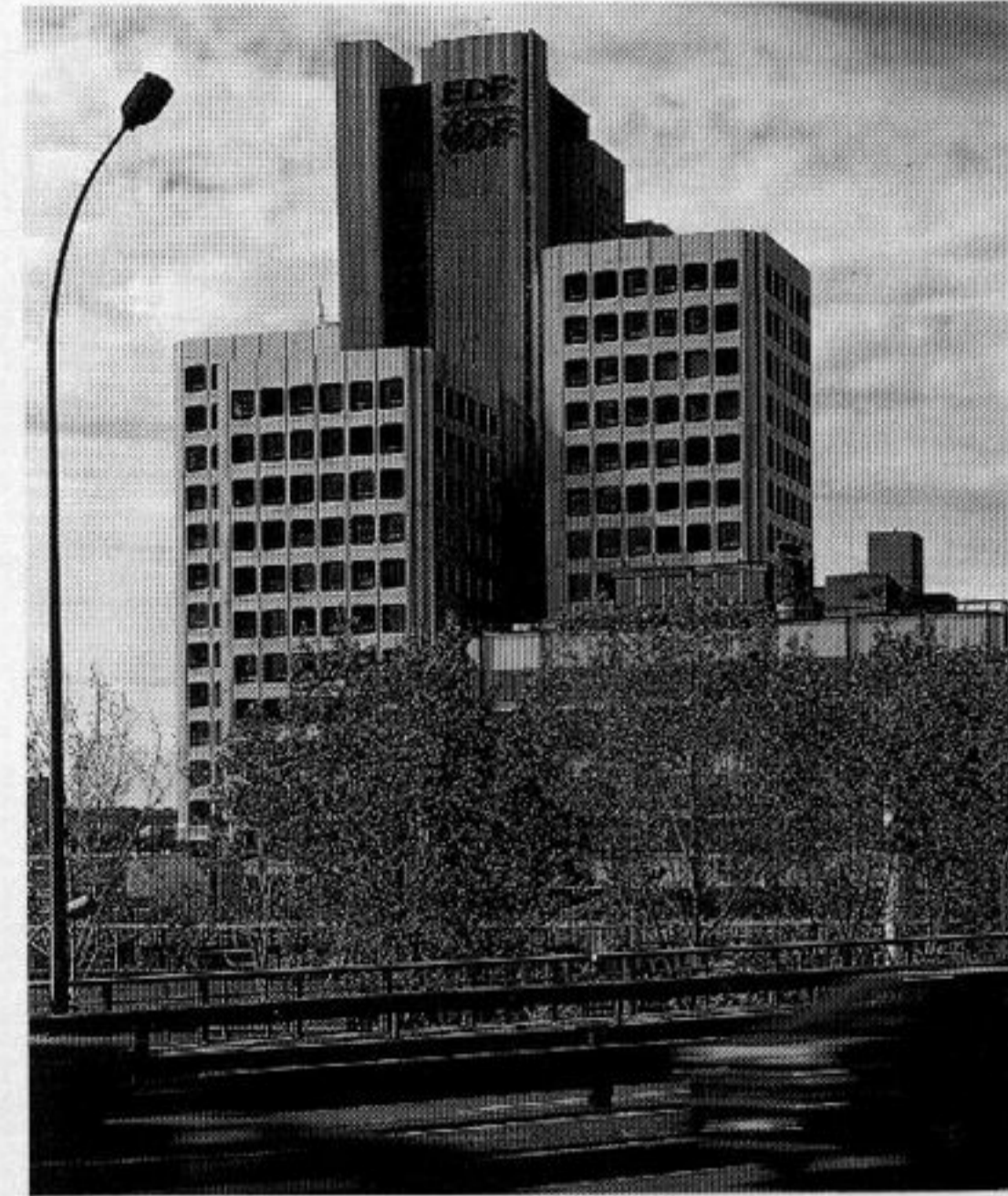
Atelier de Montrouge, offices of Électricité de France , Porte de Sèvres, Paris (1970)
