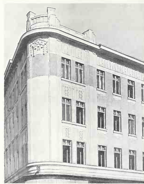
Emil Hoppe. Apartment house, Ottakringerstrasse 82, Vienna, 1906-07. ( Der Architekt )
