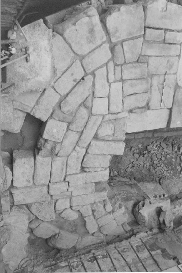
Figure 6. Caesaraugusta. Interior fill of a tower, San Juan de los Panetes area. Photo: F. Escudero.
