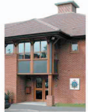
le poste de police police station
