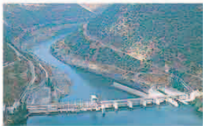
le barrage dam
