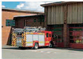
le poste d'incendie fire station
