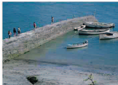
la jetée jetty
